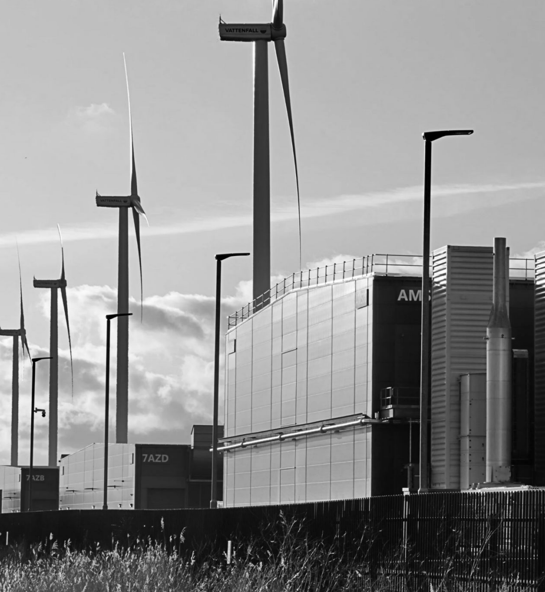
Microsoft datacenter. De stroom wordt geleverd door het windmolenpark Wieringermeer van Vattenfall. © Br Lang / Hollandse Hoogte
